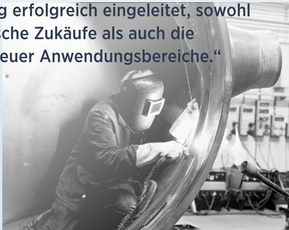
Schweißarbeiten an einem Speisewasservorwärmer für ein Kernkraftwerk
