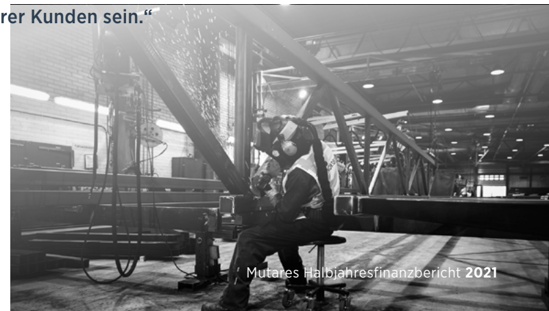
Fertigungsteile für eine Autobahnbrücke
