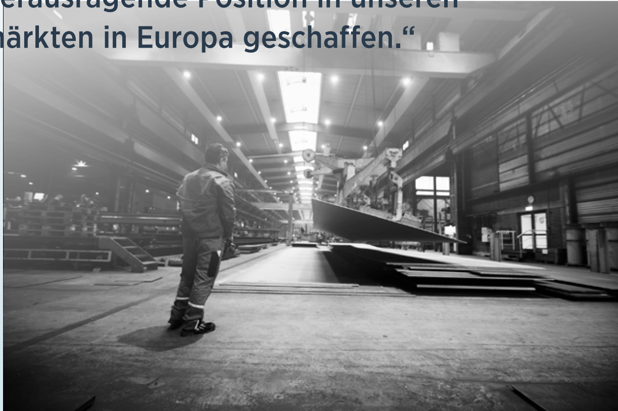
Fertigungsteile für eine Autobahnbrücke
