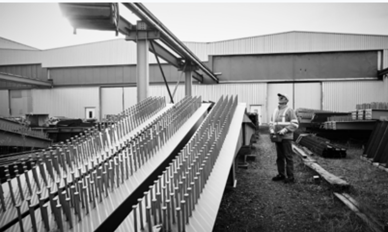
Donges Group: Bauteile für eine Autobahnbrücken
