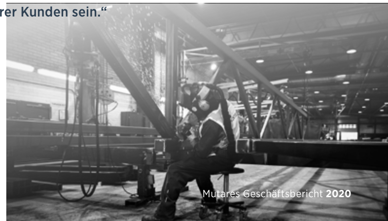
Fertigungsteile für eine Autobahnbrücke
