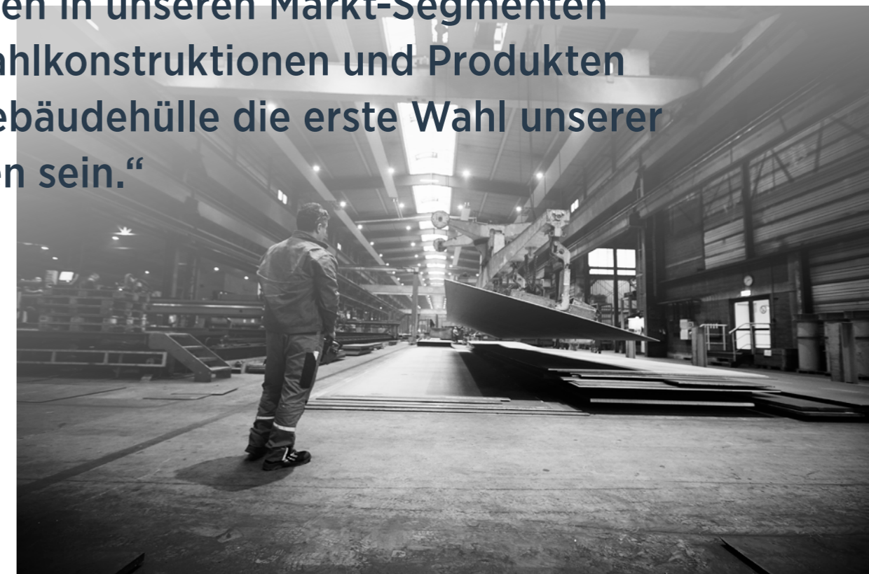
Fertigungsteile für eine Autobahnbrücke
