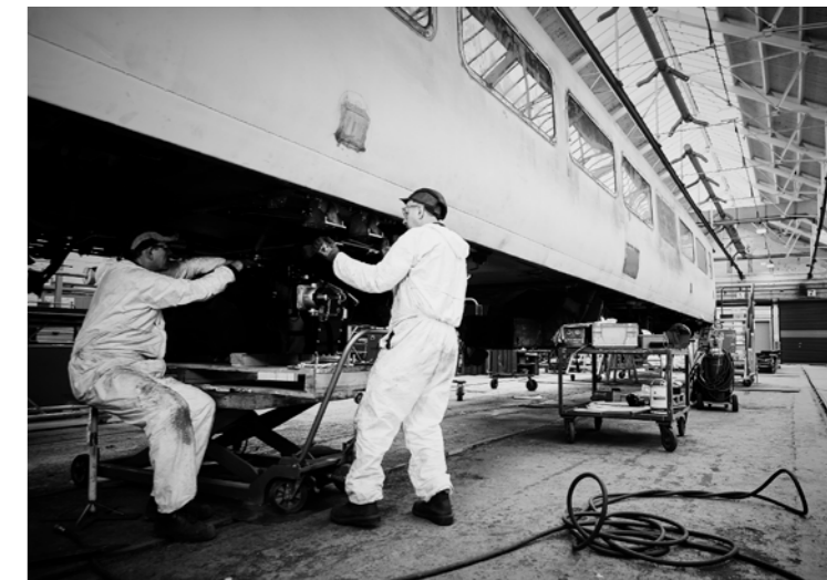
Austausch der Klimaanlage-technik bei einem Zug des Typs 156
