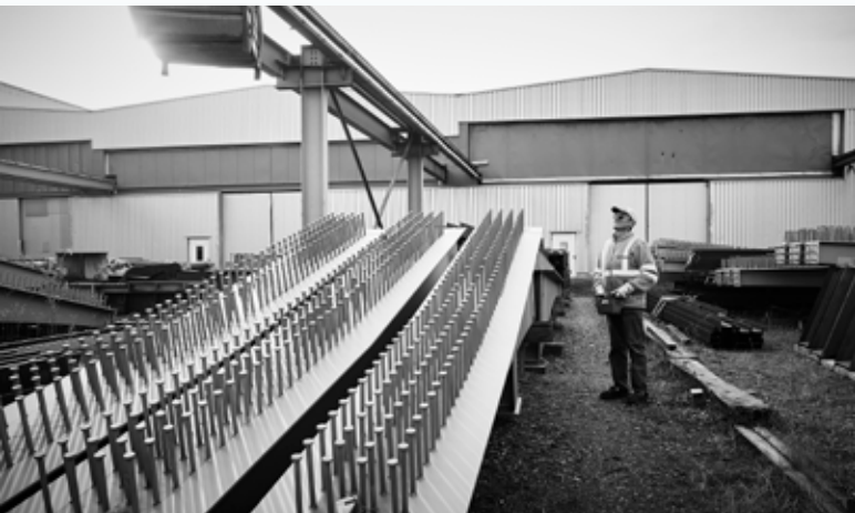
Donges Group: Bauteile für eine Autobahnbrücken
