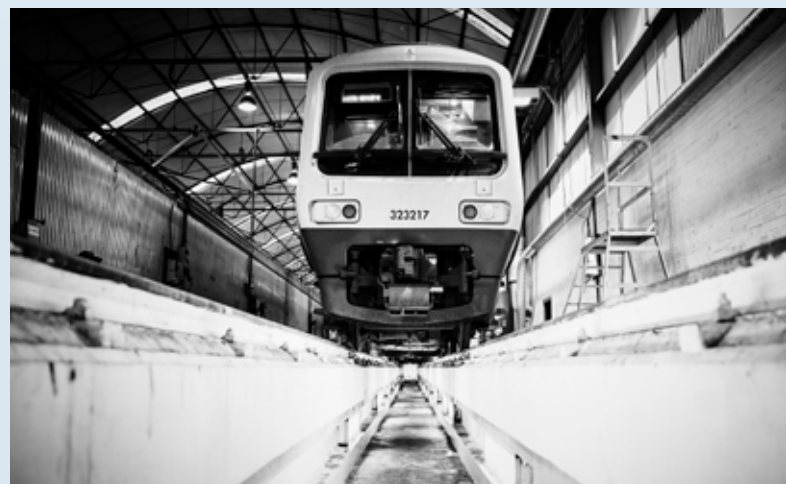
Wartungspit bei Gemini Rail Group
